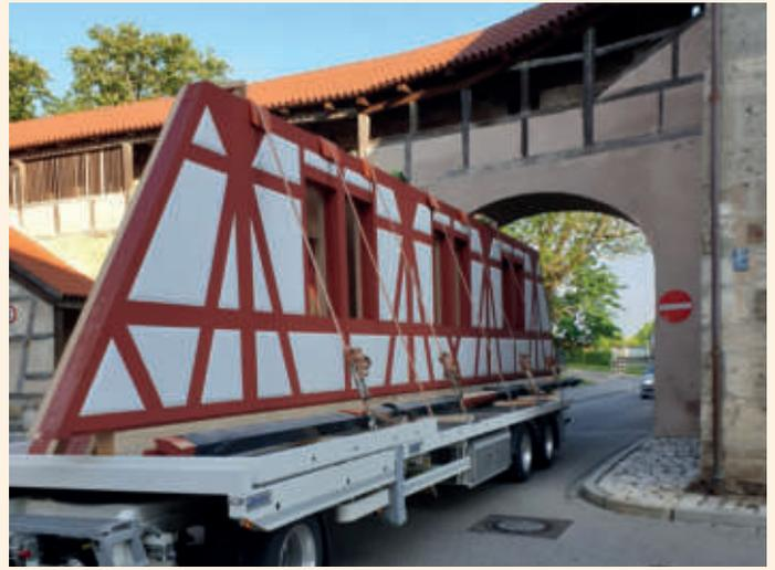
*Denkmalsanierung mit Erneuerung des historischen Fachwerkgiebels in der Nördlinger Altstadt: der neue Fachwerkgiebel wurde komplett im Werk vorgefertigt, gestrichen, verputzt und originalgetreu nachempfunden. Die fertigen Elemente wurde dann in einem Tag vor Ort montiert.*
